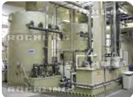
Polystone® Р гомополимер серый Установка для очистки отработанного воздуха
